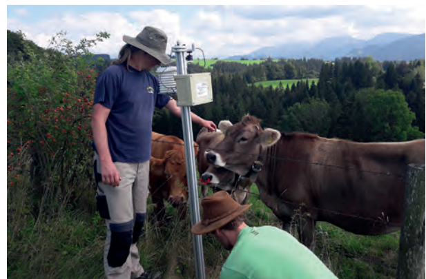
Fig. / Abb. 11: Pyranometer installation during the measurement campaign within the joint project "MetPVNet" in Allgäu, 2018 / Pyranometer-Installation während der Messkampagne im Rahmen des Verbundprojekts „MetPVNet“ im Allgäu, 2018. (Photo: Jonas Witthuhn / TROPOS).
