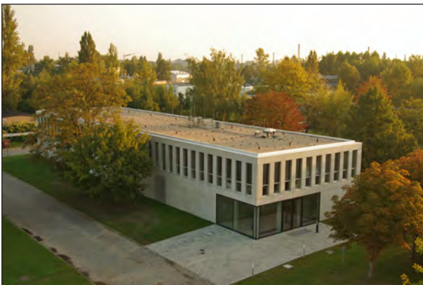
Fig. / Abb. 2: TROPOS multi-purpose building. / TROPOS-Mehrzweckgebäude.
